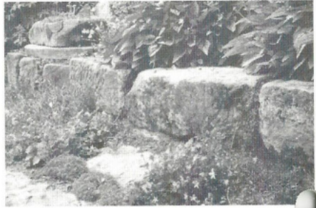
Trockenmauern sind gute Wärmespeicher und können deshalb gut mit Anbauflächen kombiniert werden.
