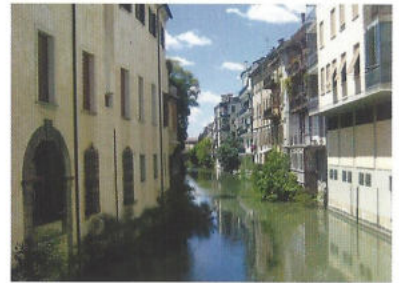
Nach vielen Überschwemmungen wurde bereits im 19. Jh. der 3 m tiefe Kanal durch die Stadt gebaut.
