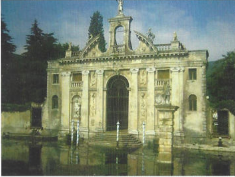
Wassertor mit Gartenteich, hinter dem sich die Villa Barbarigo in Valsanzibio nördlich von Arquà befindet.
