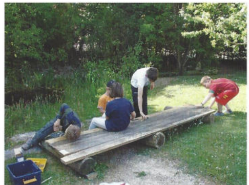
Die Brückenbauarbeiten wurden mit vollem Elan betrieben.
