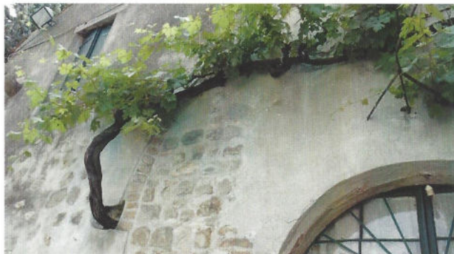
Ein Weinstock aus dem Haus? Er wächst aus der Erde auf der anderen Straßenseite. Die Straße und das Haus wurden darüber gebaut.
